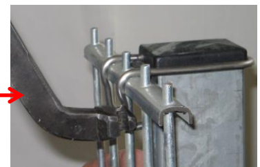
Klammern werden befestigt
